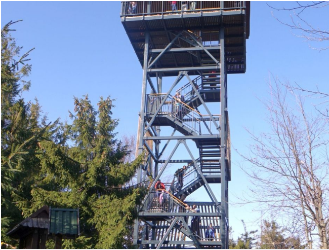
Stalowo-drewniana wieża widokowa na szczycie Mogielicy (stan z 2022 r.), z turystami wchodzącymi po schodach — dobrze widać skalę obiektu.
